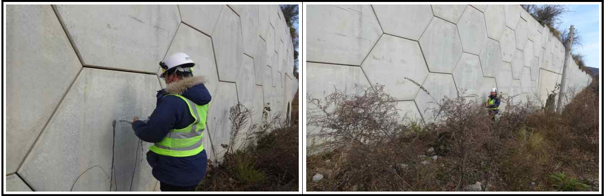
【그림 1.3.6】 슈미트해머를 이용한 반발경도시험 전경
